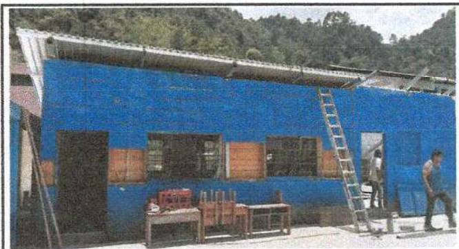
Foto 3: Se observa el avance de los trabajos realizados en los salones del modulo 1, estructura de techo, puertas, ventanas, vidrios.
