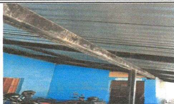
Foto 2: Se observa el avance de trabajo realizado en la cubierta de lámina en el módulo 2.
