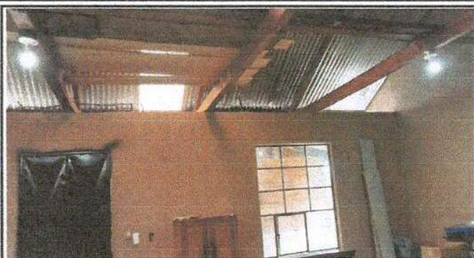
Foto1: Se observa el avance de cambio de cables y accesorios del sistema eléctrico en el módulo 1, 2 y 3.
