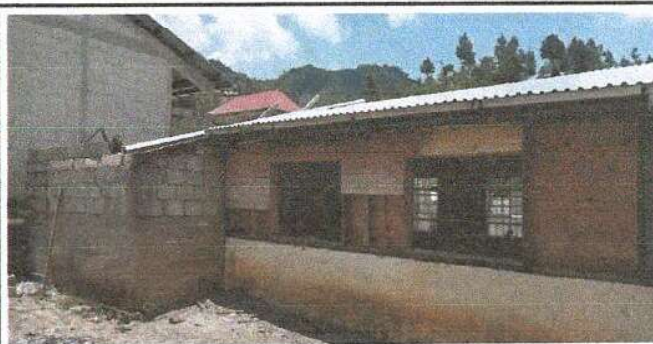
Foto 4: Se observa en la parte posterior el avance de los trabajos realizados en instalación de cubierta de lámina perteneciente al módulo 1.
